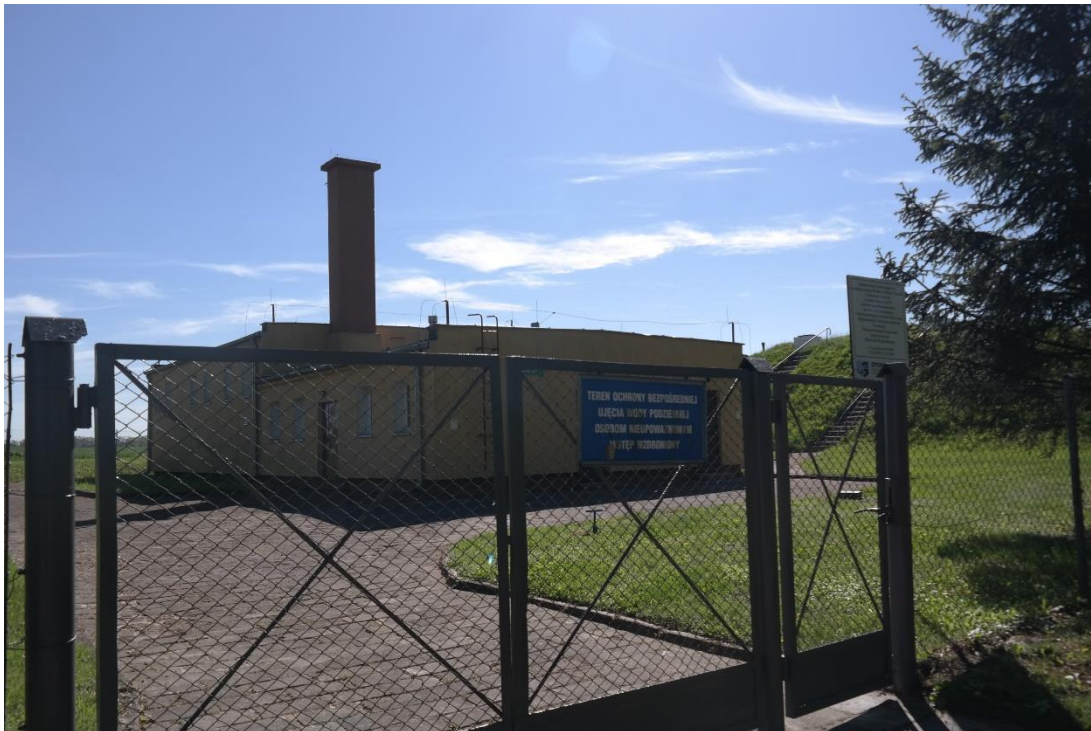
Zdjęcie 7. Teren ujęcia wody w Kazaniu
