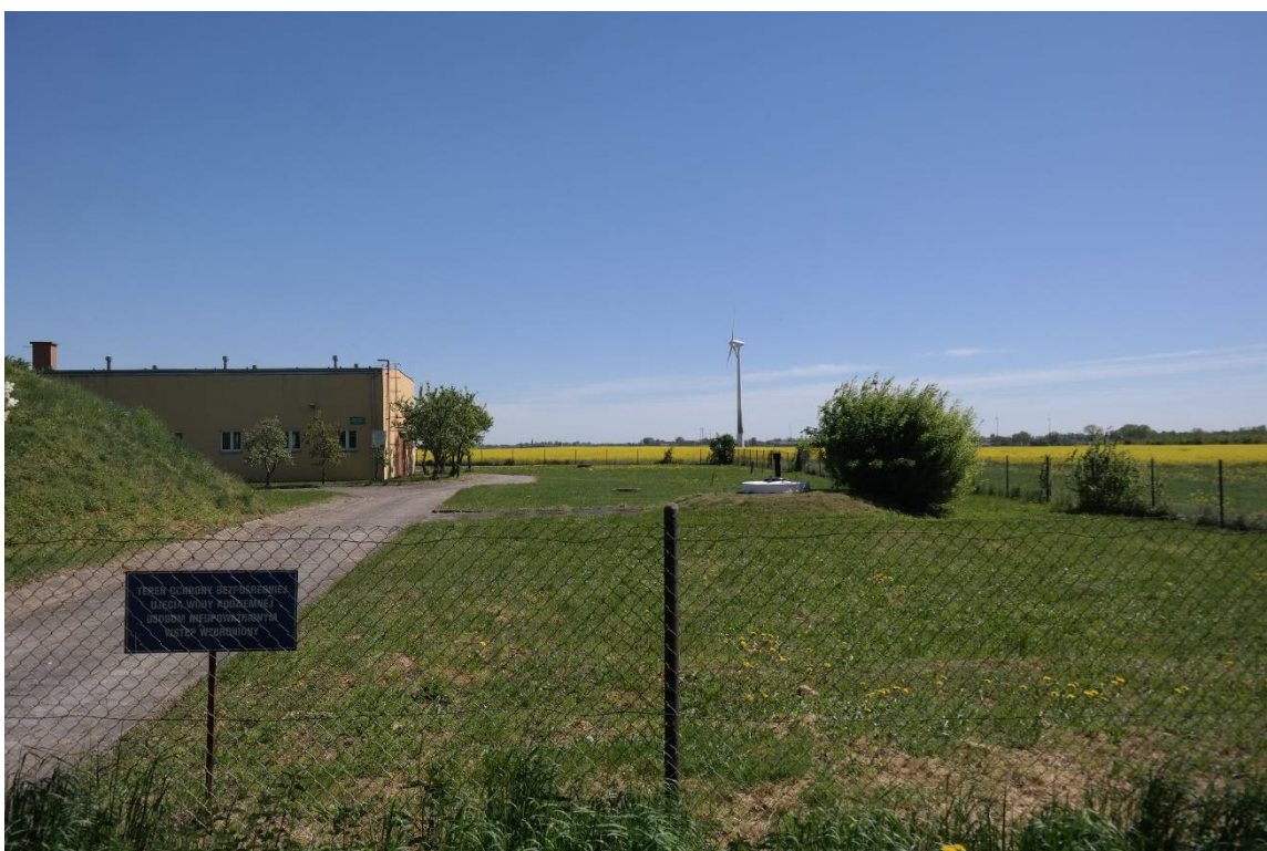
Zdjęcie 29. Teren ujęcia wody w Żydowie
