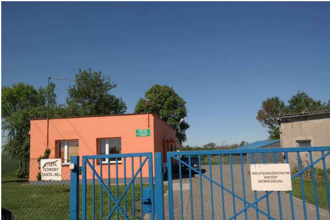
Zdjęcie 13. Oczyszczalnia ścieków w miejscowości Lubraniec - Marysin
